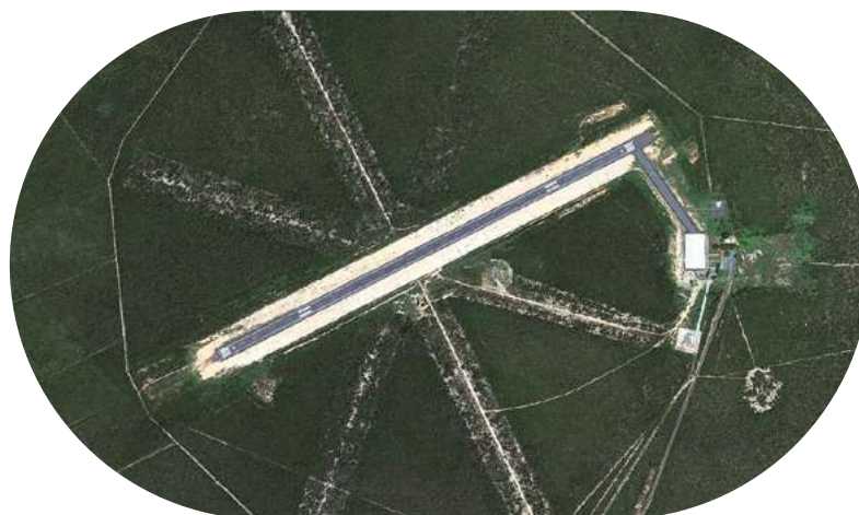
Vista aérea do aeroporto de Barreiras
