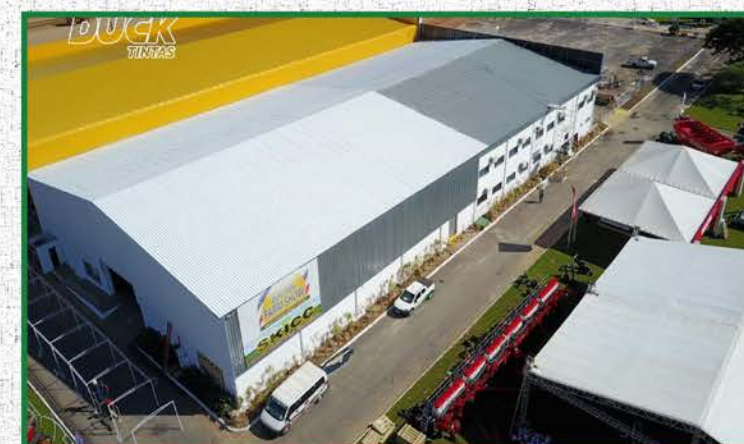
Aplicação da Tinta Térmica no Barracão da Bahia Farm Show / ABAPA.
