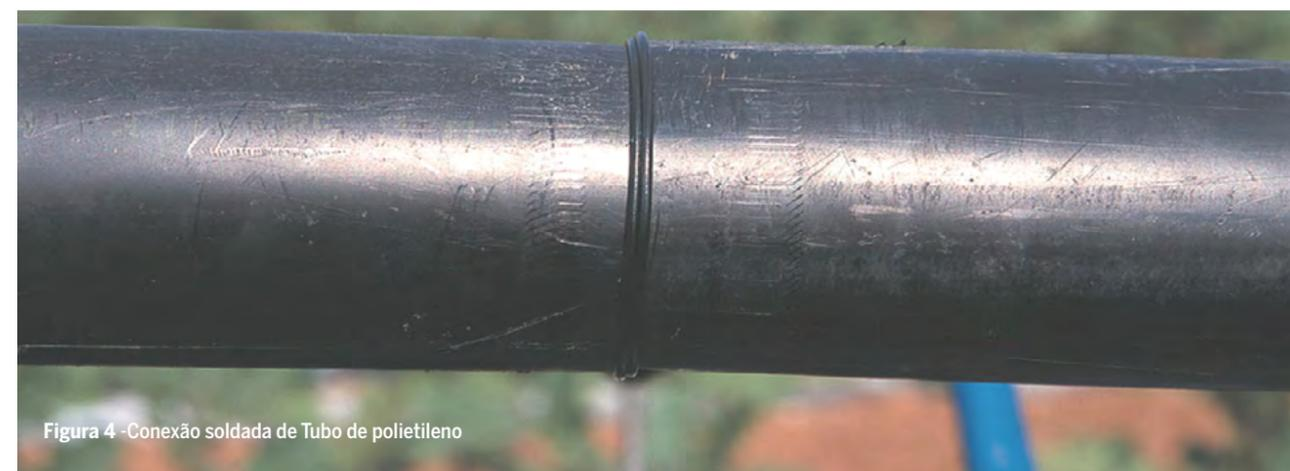
Figura 4 - Conexão soldada de Tubo de polietileno
