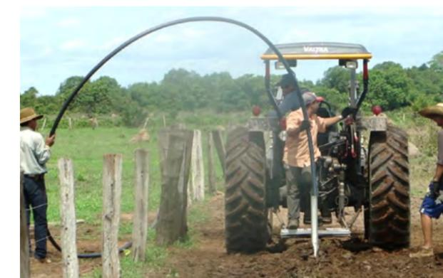
**Figura 2 - Enterrio de tubo de polietileno. Foto fornecida por: Terra Molhada/GO**
