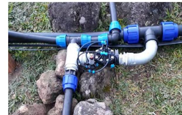
**Figura 1 - Instalação de tubulação superficial de polietileno em terreno com grande declividade.**
