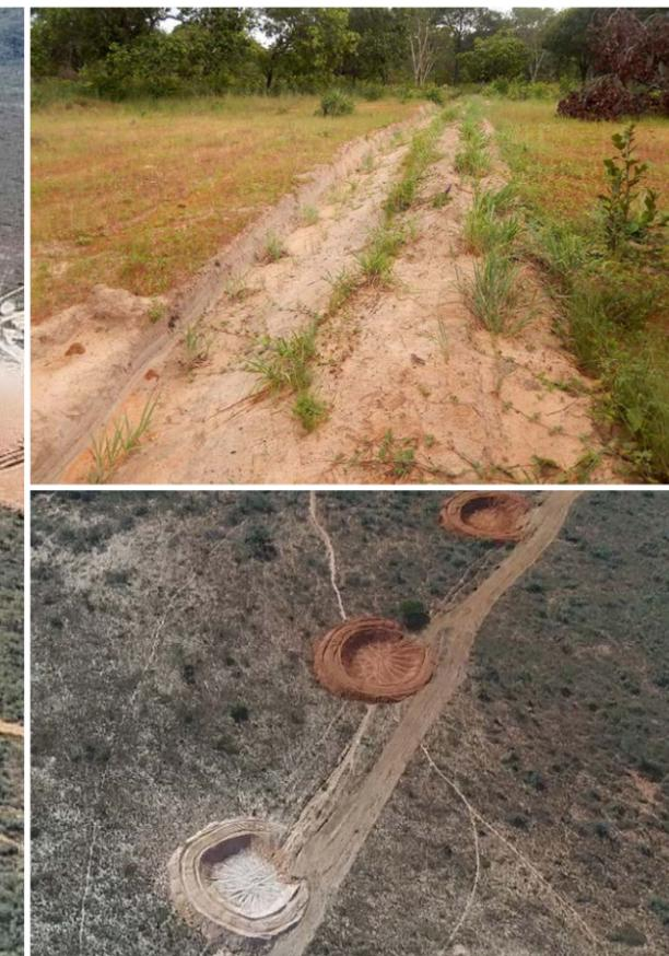
**FIGURA 2** - Detalhe das estruturas que controlam o escoamento superficial e favorecem a infiltração de água da chuva no solo: barraginhas (A) e terraço (B).
