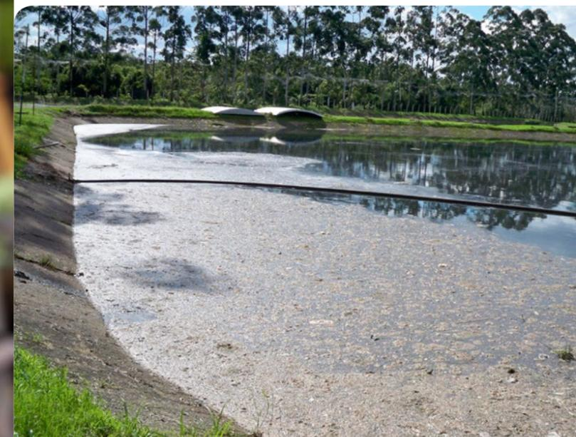
nismos decompositores e a própria matéria orgânica digerida do esgoto se acumulam no fundo dos tanques das Estações de Tratamento de Esgoto (ETEs).
