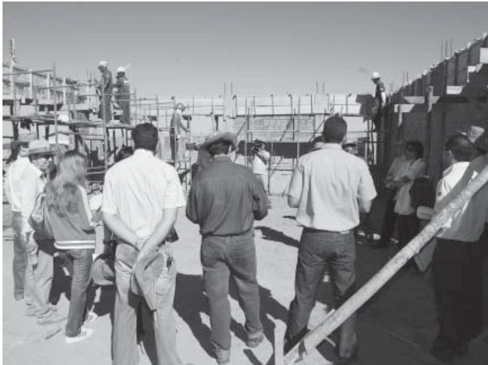
Executivos da Aiba, Abapa, Fundação Bahia e Fundeagro vistoriam as obras
